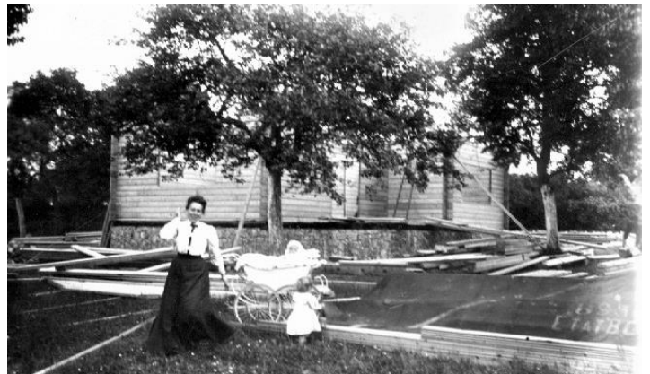
Le chalet en construction
